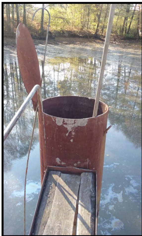
Stávající výpustné zařízení s lávkou
