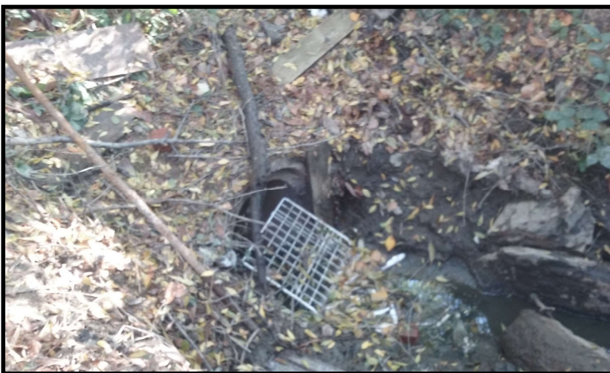
Stávající vtok do zatrubněné vodoteče
