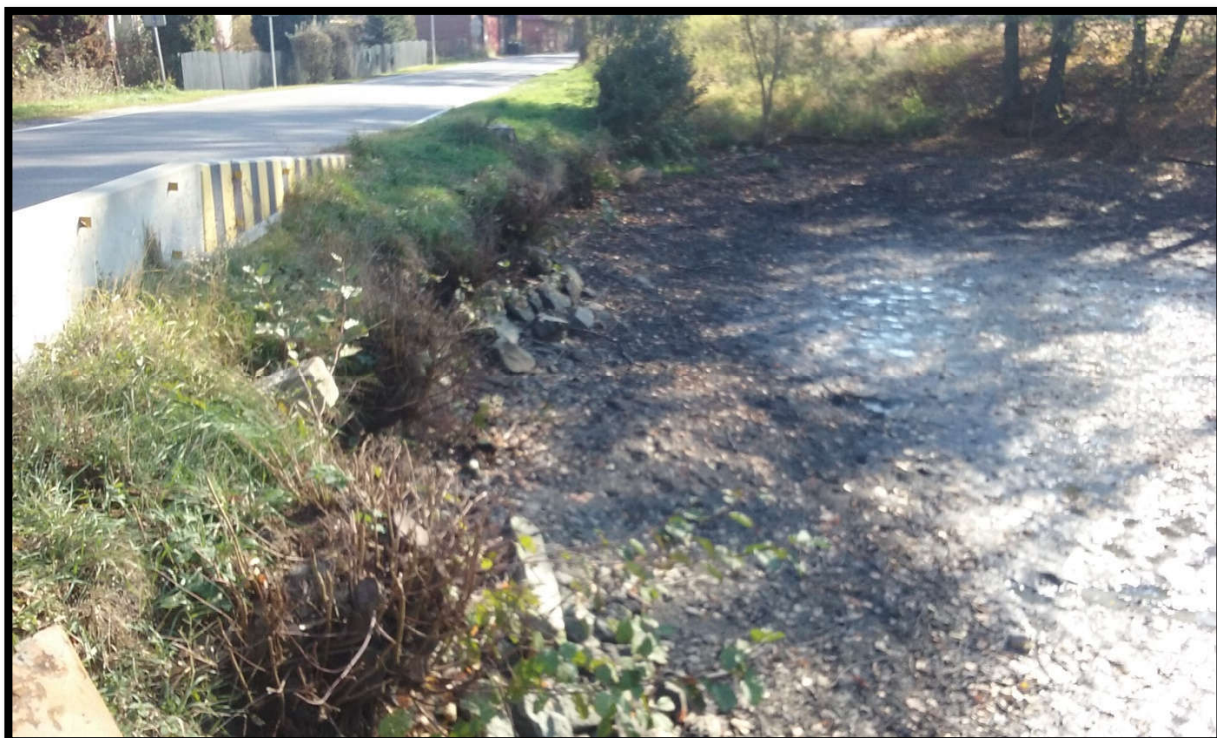
Degradovaný návodní svah tělesa hráze s nátržemi
